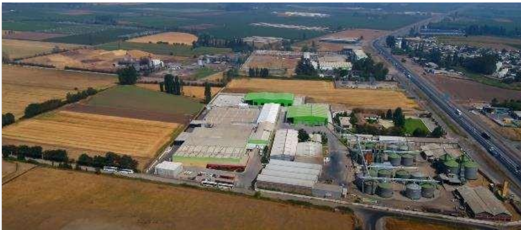
Planta Industrial San Francisco de Mostazal
